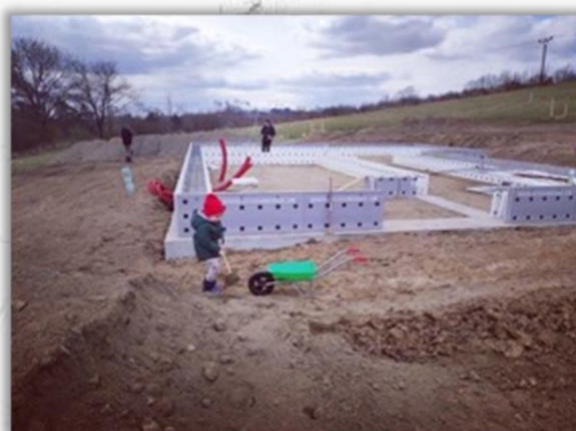
REALIZACE ZÁKLADŮ OBVODOVÉ A VNITŘNÍ TVAROKY TERMO
