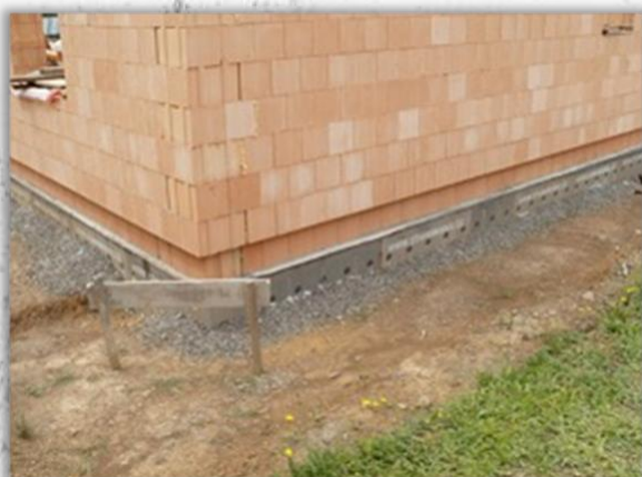
NEJJEDNODUŠŠÍ ŘEŠENÍ ZATEPLENÝCH ZÁKLADOVÝCH SOKLŮ
