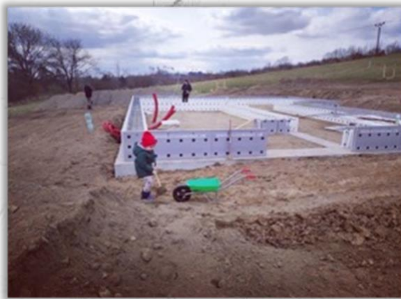
REALIZACE ZÁKLADŮ OBVODOVÉ A VNITŘNÍ TVAROVKY TERMO
